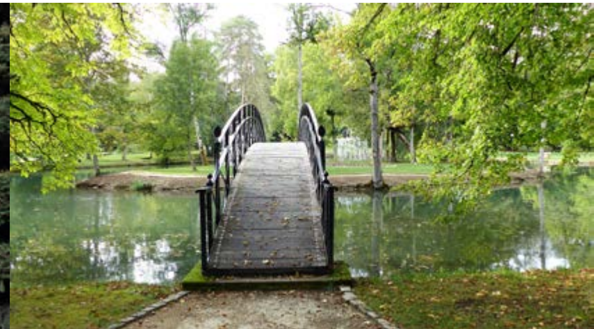
Rundbogenbrücke über den Parkweiher
